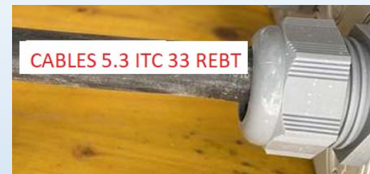
CABLES ELÉCTRICOS NO ARTOS
