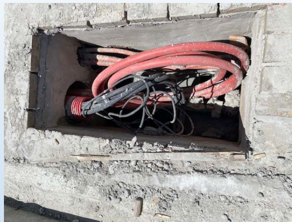
TRABAJOS EN PROXIMIDAD DE INSTALACIONES EN TENSIÓN
