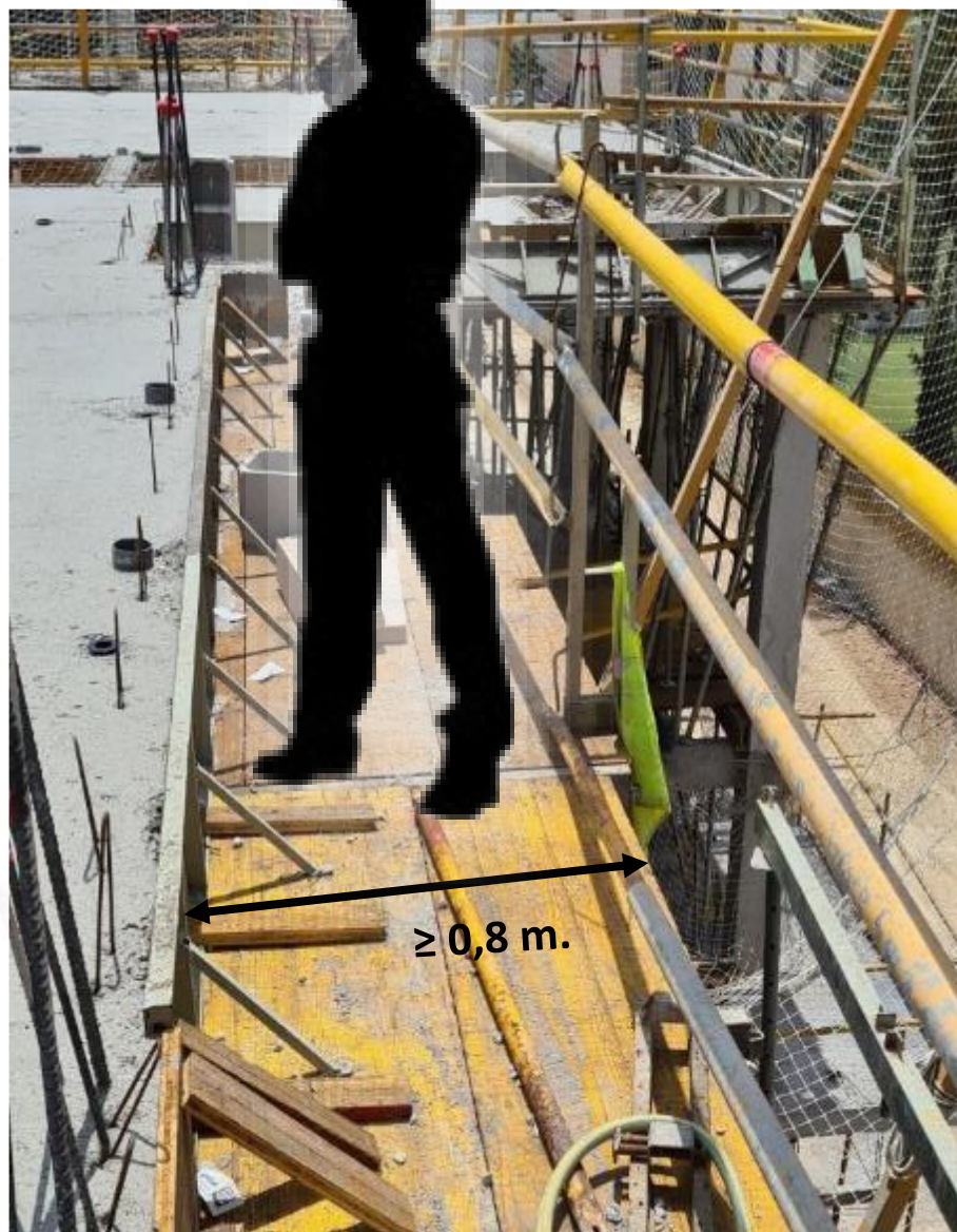
Barandilla tipo sargento a retirar para pasar al forjado ya hormigonado
