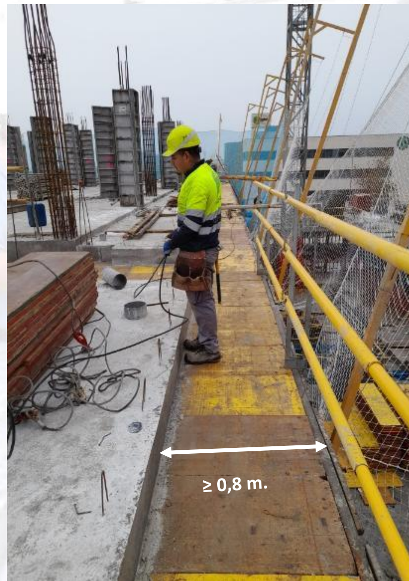
Barandilla tipo sargento a retirar para pasar al forjado ya hormigonado
